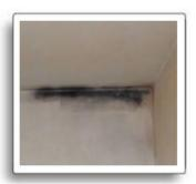
L'origine del vapore acqueo è da ascriversi al processo di respirazione degli abitanti, alla "produzione interna" di vapore delle cucine e dei bagni, ecc. ed alla "restituzione" dell'acqua da parte dei muri.
